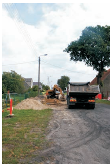
fot. Prace w Suliszewie
