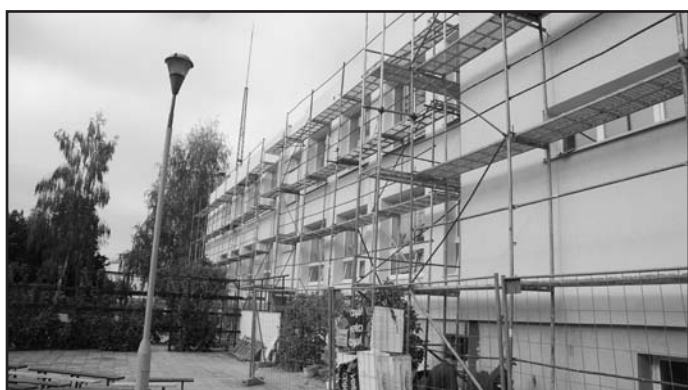
Termomodernizacja Przedszkola Nr 4 (ul. Mur Południowy 4)
