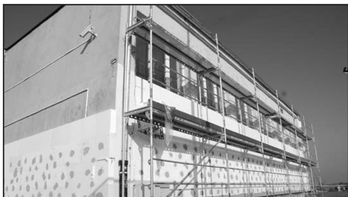
Termomodernizacja Szkoły Podstawowej Nr 3
