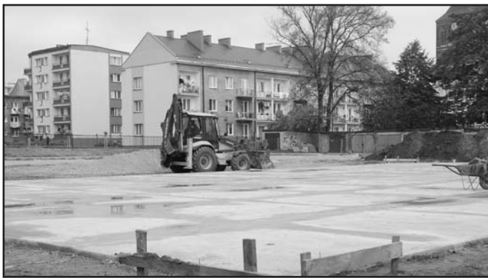
Budowa boiska „Orlik 2012” (vis-a-vis Gimnazjum)
