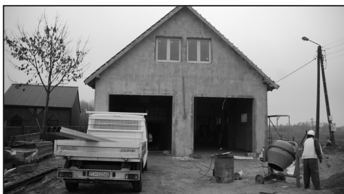
Remont remizy OSP w Suliszewie.
