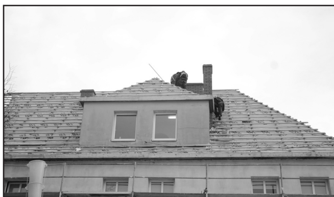
Remont dachu w Przedszkolu nr 1.
