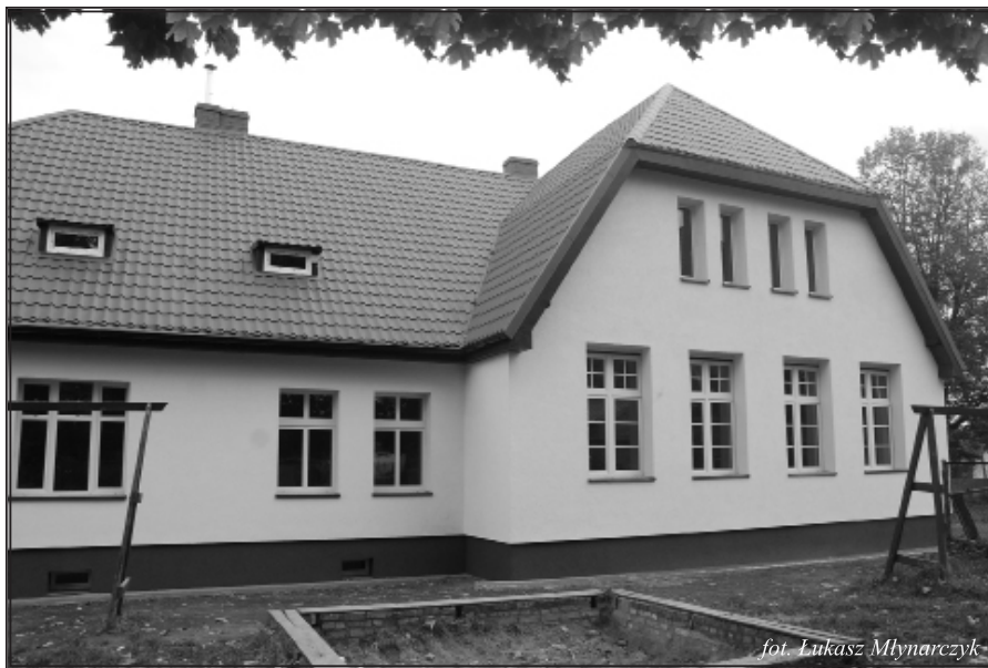
Wyremontowana świetlica w Rzecku.
